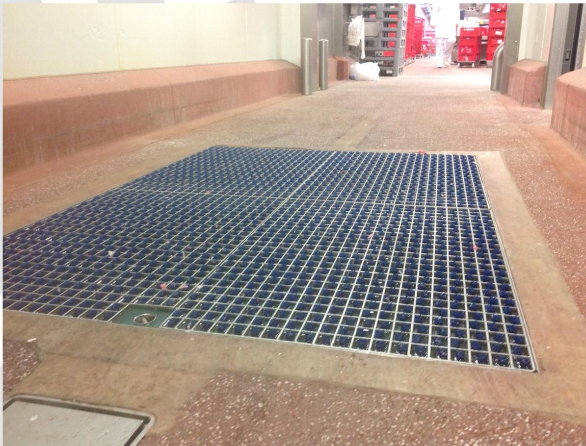
Il Sistema ProfilGate® è la miglior soluzione per bloccare trucioli di metallo o di legno che possono rimanere attaccati ai carrelli della manutenzione evitando di contaminare le aree più sensibili della produzione.
